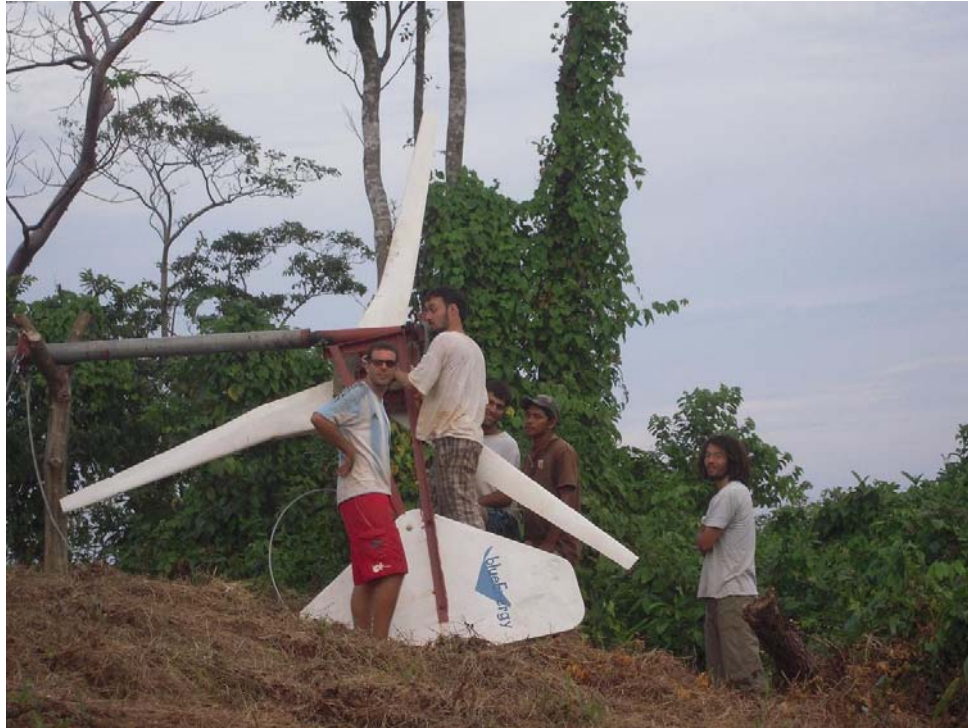
El ingeniero van Dam trabajando con el equipo técnico y operadores locales en la instalación de una turbina
